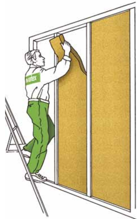
Verlegung der PAVAFLEX Dämmplatten.
