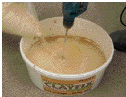
Miscelare il contenuto del secchio con acqua
