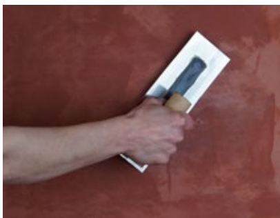
Esecuzione dello spatolato veneziano
