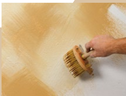
Applicazione del secondo colore
