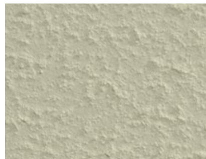
Struttura di una superficie in pannelli in cartongesso ben preparata
