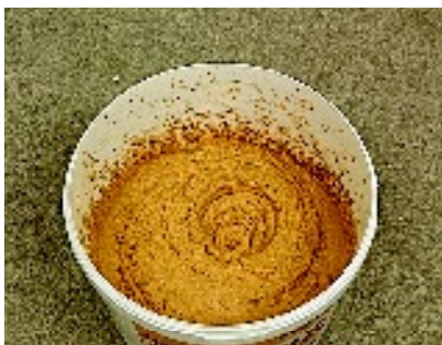
Dopo 30 minuti lavorare a fondo, l'immagine mostra la consistenza giusta per l'applicazione
