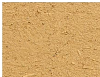
Struttura di una superficie in intonaco di fondo in argilla ben preparata
