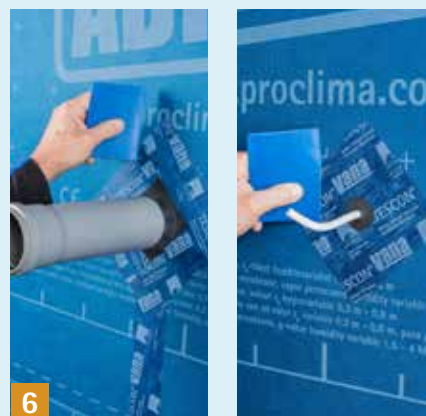
6 Passaggi per tubi CON ROFLEX/KAFLEX.
