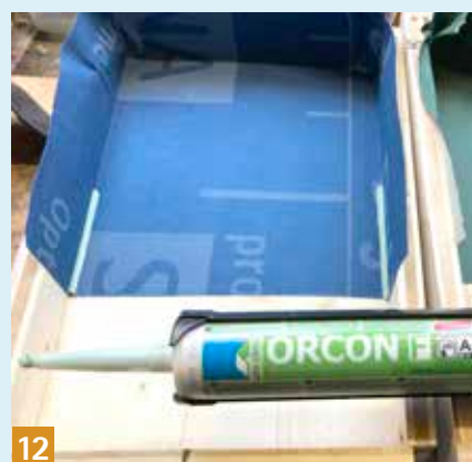
12 Sigillare ulteriormente la parte sovrapposta delle membrane con ORCON F.
