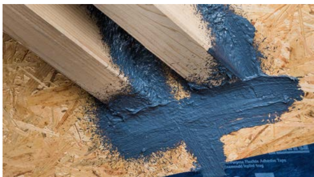
9. Raccordo su passaggio trave terminato
